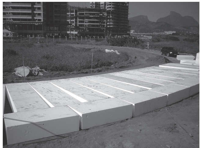
Fig. 1.9 Geoblocos em obra de aterro Foto: cortesia de Sandro S. Sandroni.
