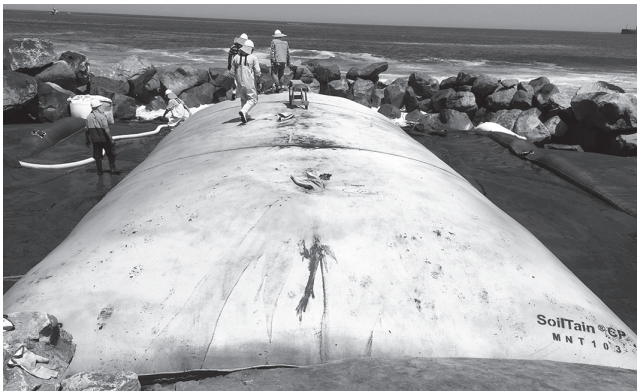
Fig. 1.11 Geofôrma Foto: cortesia de Huesker.
